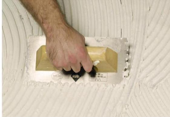
Para formatos superiores a 30x30cm, es necesario la técnica del doble encolado, que consiste en la aplicación del adhesivo tanto sobre la superficie de colocación como sobre el dorso de la baldosa cerámica, para ello utilizaremos la llana dentada; y su aplicación se debe hacer en el piso con la parte dentada y sobre la baldosa por la parte lisa, este paso mecánico garantizará la correcta adherencia del material de pega en la parte más vulnerable del agarre.
