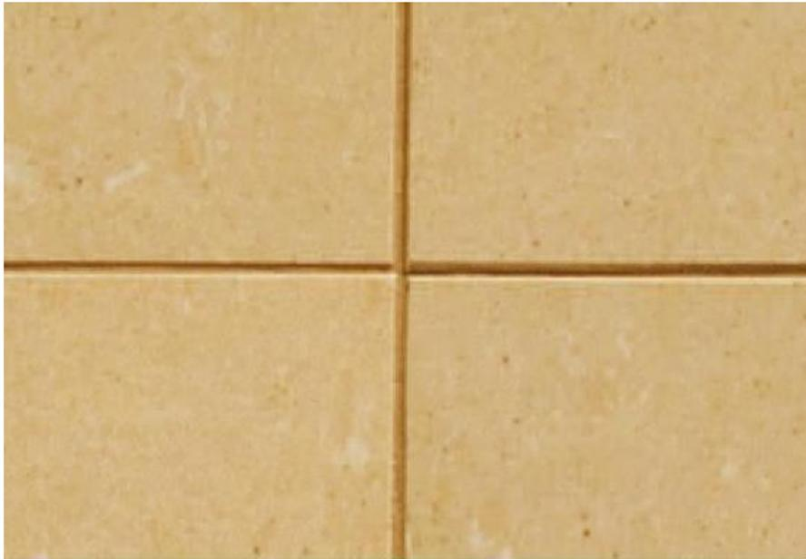
El relleno de juntas se realiza cuando las baldosas se encuentren perfectamente adheridas al soporte. En el caso especial del piso porcelánico, se deben seguir las recomendaciones del fabricante de adhesivos, con el fin de dejar transcurrir el tiempo suficiente antes de ser pisado o sometido a cualquier tipo de carga.
