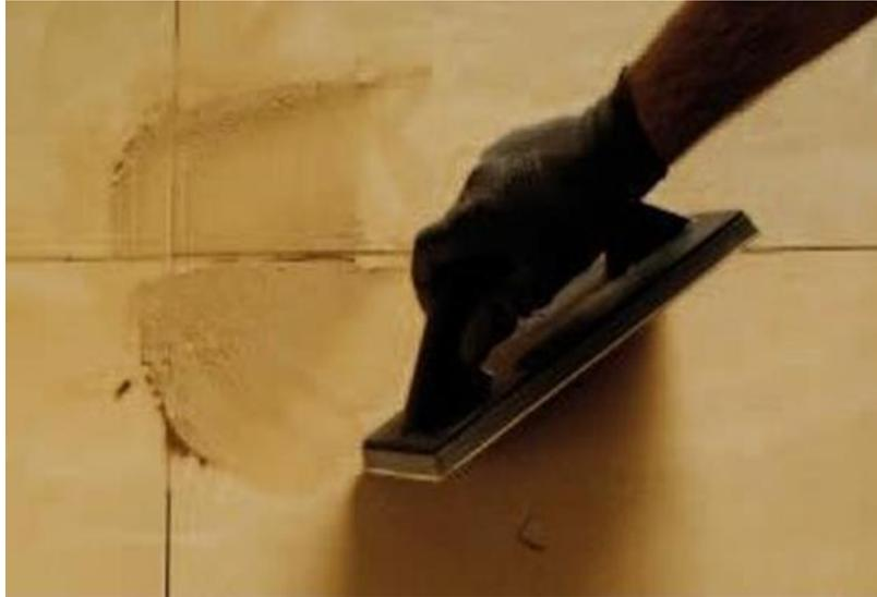
El material de emboquillado se aplicará con llana de goma, evitando en todo momento la utilización de llanas metálicas, que puedan dañar la superficie esmaltada. Existe en el mercado material de boquilla en una amplia gama de colores para poder asegurar la uniformidad de tono de cualquier ambiente. No se debe utilizar nunca junta de color negro, que contenga negro de humo (Carbón micronizado), ni tintes que puedan dificultar la limpieza de la superficie revestida.
