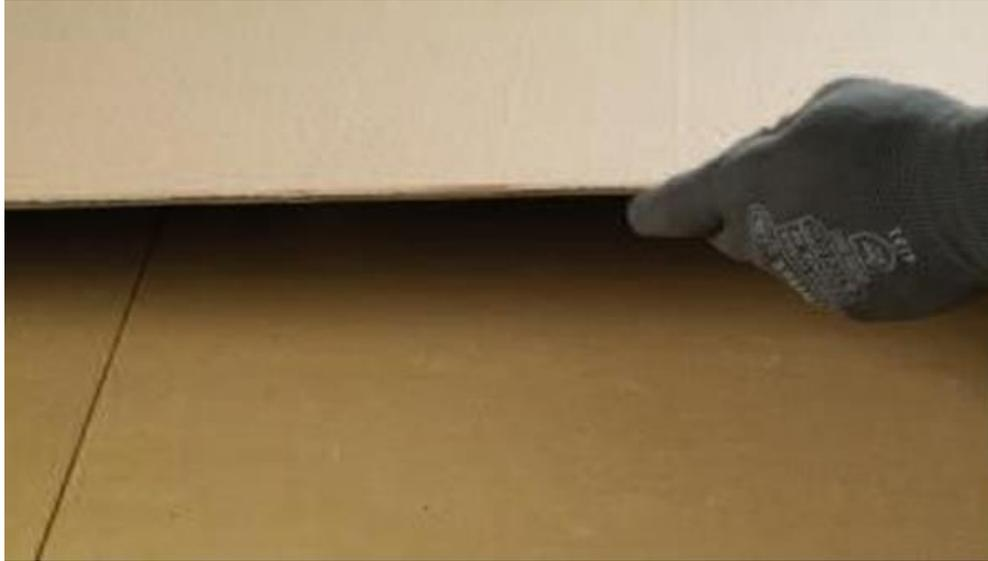
En la instalación de pisos es imprescindible la protección del material ya colocado con sistemas adecuados para impedir posibles daños hasta la finalización de la obra, debido a la presencia del material abrasivo y continuo trasiego de materiales. De esta forma, además de la protección del material, se facilitan así las posteriores tareas de limpieza.
