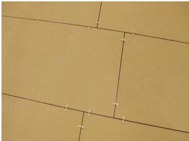
Durante la colocación, la intensidad de luz debe ser tal que nos permita distinguir con facilidad la presencia de cualquier defecto, en especial la aparición de desniveles entre piezas. Durante esta fase, se debe trabajar con una intensidad de luz superior a la que iluminará el ambiente una vez finalizada la obra.
