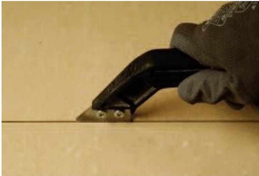
Antes del emboquillado comprobaremos que las juntas de colocación entre baldosa y baldosa están vacías y limpias del material de agarre y restos de suciedad. Cualquier agente intermedio puede restar efectividad a la boquilla de colocación, dificultando además la adherencia del material de juntas. Las boquillas estructurales siempre deben ir con silicona.
