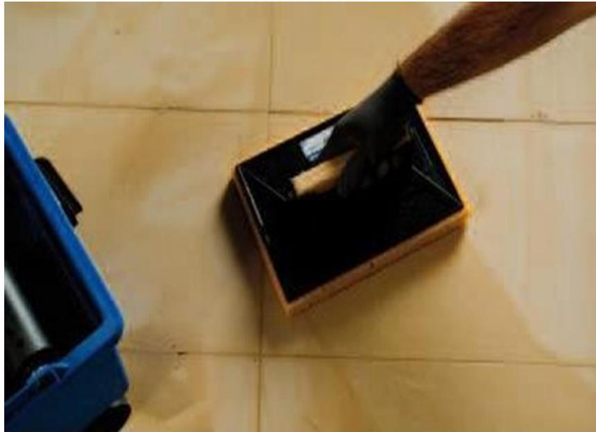
La retirada de los restos de material de emboquillado se debe realizar utilizando una esponja humedecida en agua limpia. Esta operación no se debe prolongar en el tiempo, ya que un excesivo tiempo de contacto del material de emboquillado con la superficie esmaltada dificulta la posterior eliminación del mismo, en especial aquellos modelos que su superficie presenta relieves.
