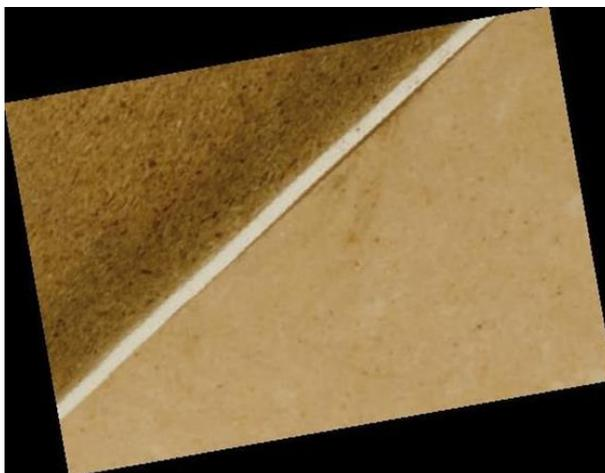
Hay que considerar en cualquier caso la presencia de juntas perimetrales que ayudarán a absorber cualquier movimiento post-obra. Estas juntas han de permanecer vacías o rellenar de cualquier material compresible y deben tener un mínimo de 10 mm.
