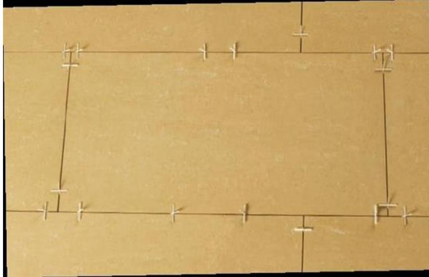
Para formatos rectangulares, cuando se colocan a junta trabada, se aconseja desplazar la junta hasta un máximo del 20% del lado más largo según sea el formato.
